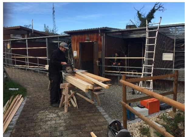
Umbau von Kleinvogelvolieren im November 2020.
