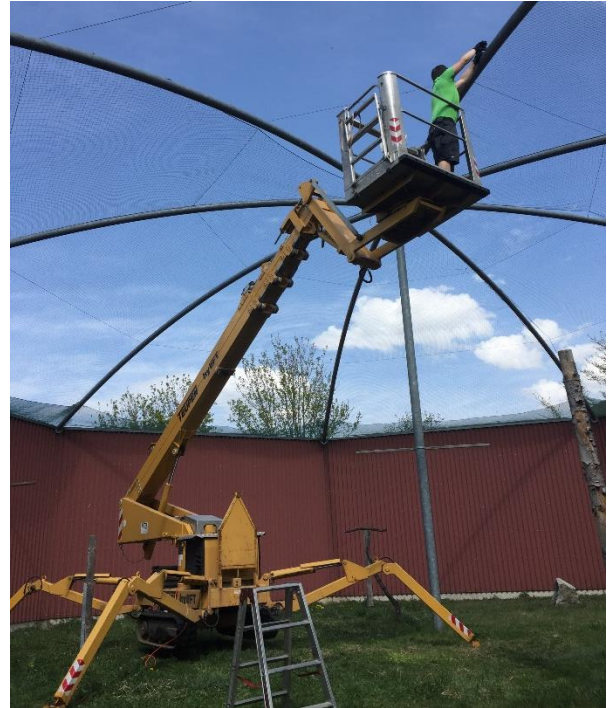
Arbeiten zum Austausch der Netzabdeckung über der Rundvoliere am 17.04.2020.
